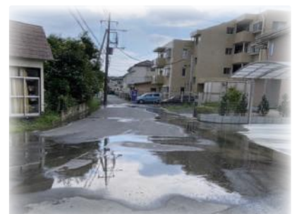
道路漏水参考写真
