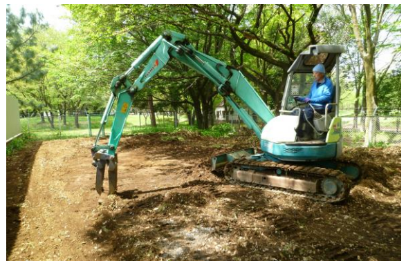
島崎土建さんが、彩の森公園に隣接するプール北側の敷地を活用できるように整地してくださいました。ありがとうございました。
