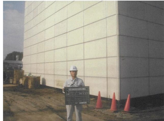
図4：防音パネルの設置状況
