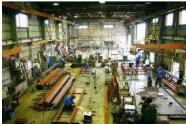
ウチノ看板(株)武蔵工場内部の様子
