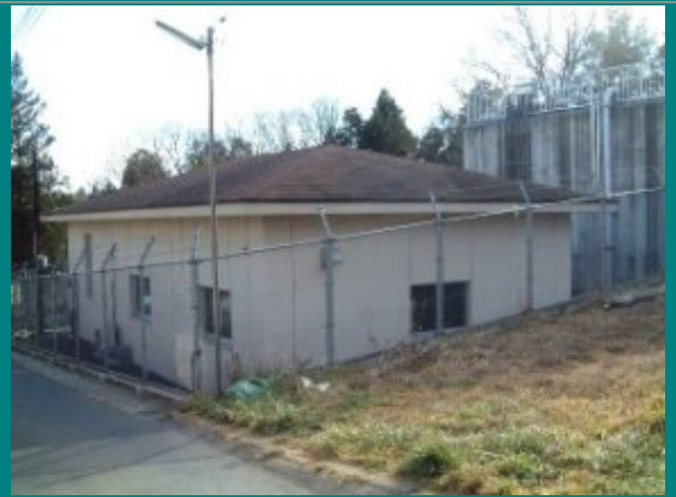
11 . 入間台加圧場
