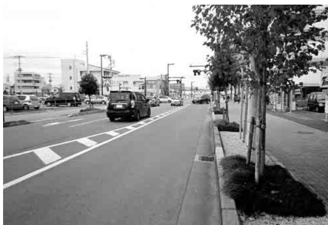
武蔵藤沢駅西口ロータリー周辺
