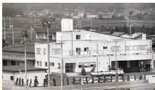
旧学校給食センター 昭和56年建設当初 (写真提供：入間市博物館)
