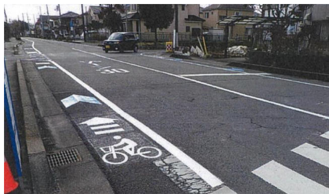
図 4-3 車道混在（矢羽根型路面表示）
