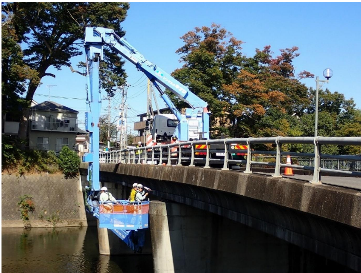
橋りょう点検の様子
