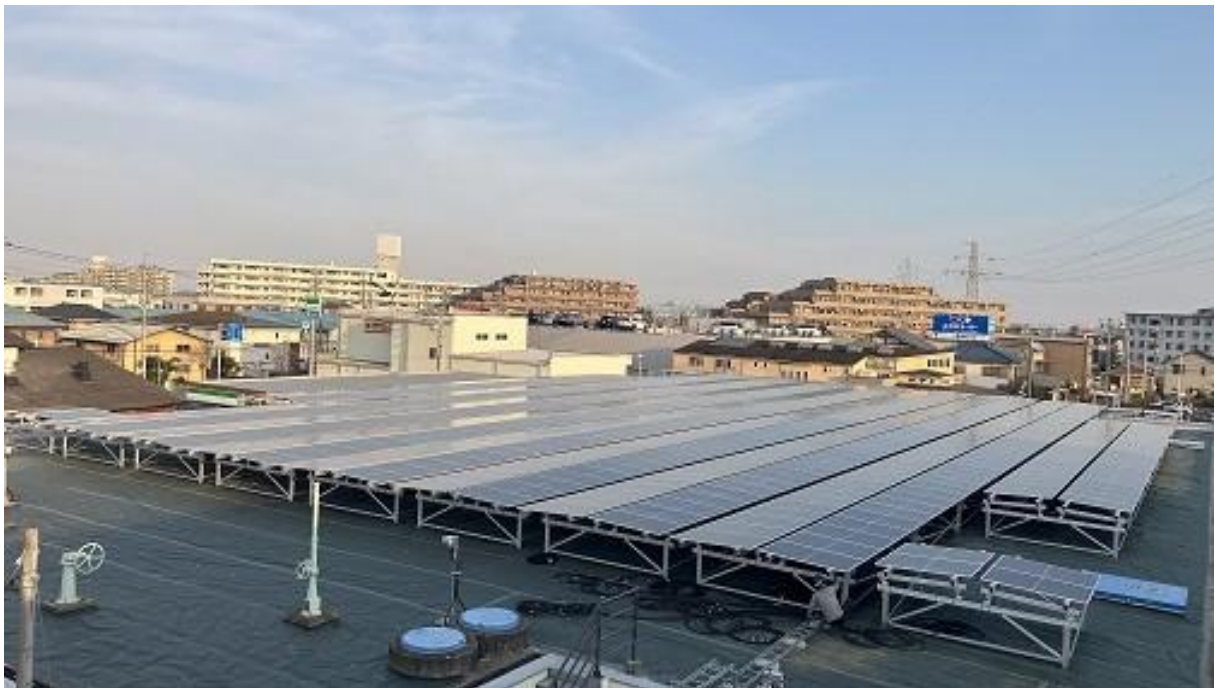
公共施設への太陽光発電設備設置の様子（扇町屋配水場）
