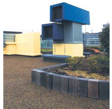
9 自然換気(重力換気)の排気口となる「風の塔」
