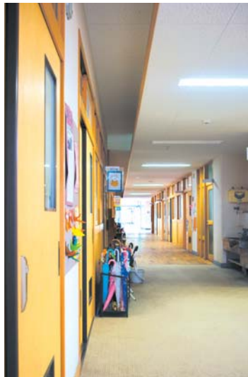
8 「風の道」の廊下上部の勾配天井により「風の筒」入口へ熱気を誘導
