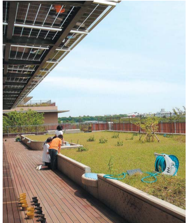
7 4学年普通教室から続く屋上緑化テラス
