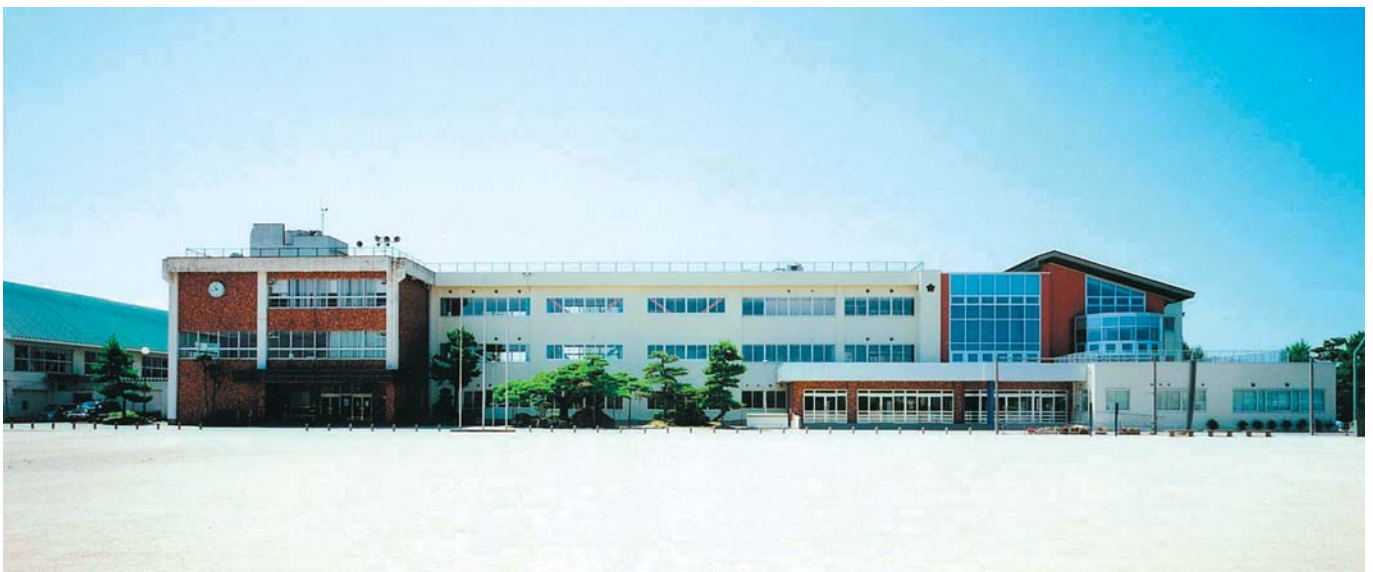
屋外運動場から見た外観 (耐震補強・改修された既存校舎と増築棟)
