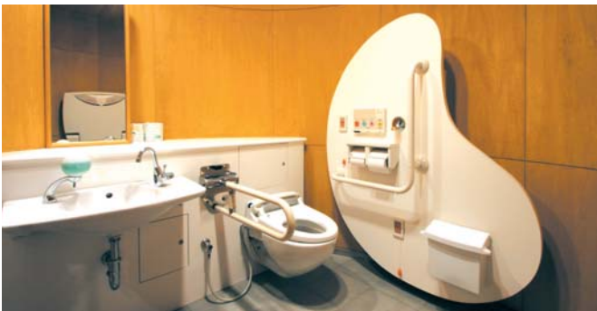
10 会議室の近傍にある地域の方も使える多目的トイレ
