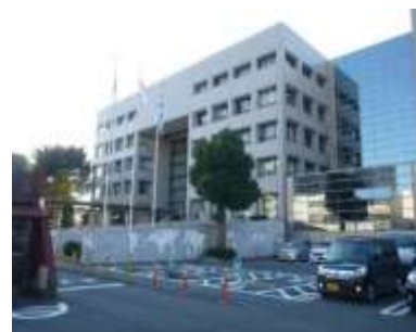
写真 市役所A・B棟
