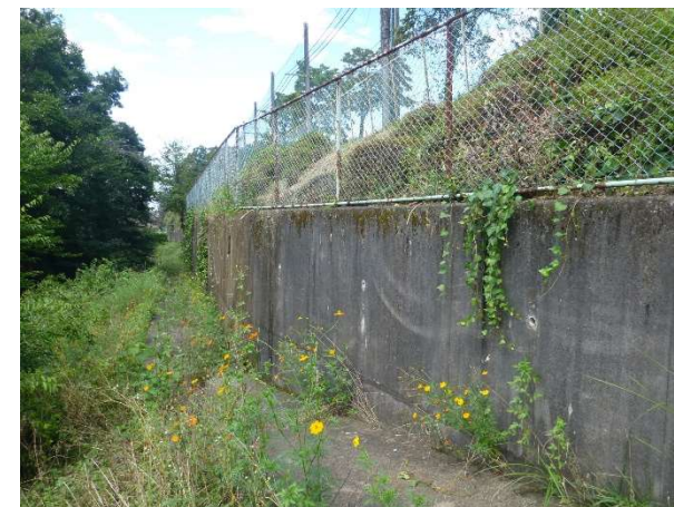
図15 西武中学校内前堀川側の擁壁
