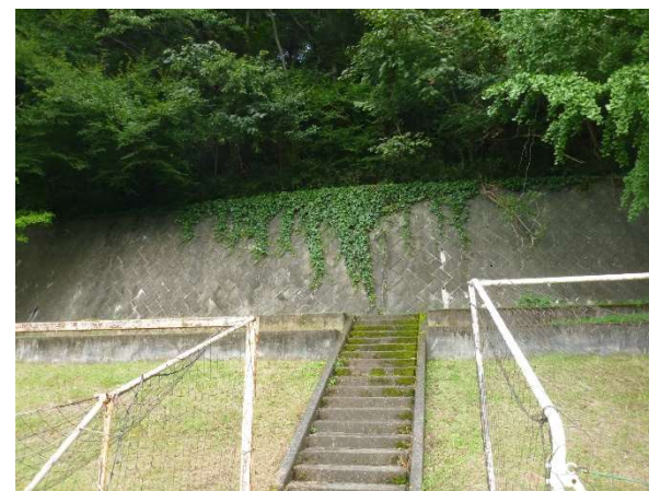
図14 西武中学校第2グラウンド斜面擁壁
