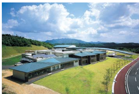
12 太陽光発電システム
