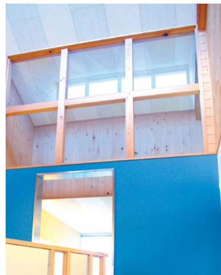
12 トップライトにより自然光で明るいトイレ
