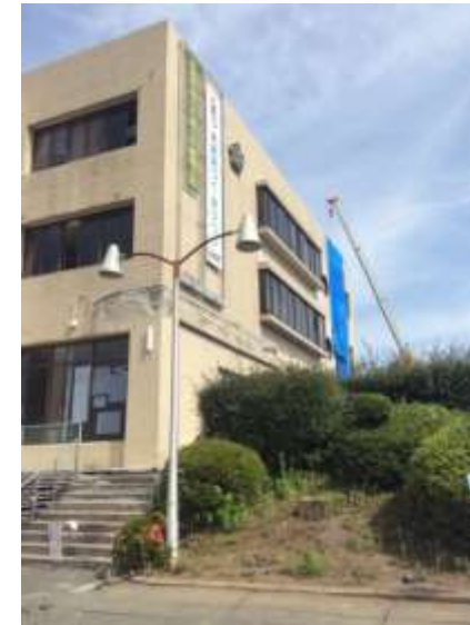
＜益城町役場＞使用不能（耐震改修済） 玄関部分、エレベータ用建物、 議会棟への渡り廊下が大破
