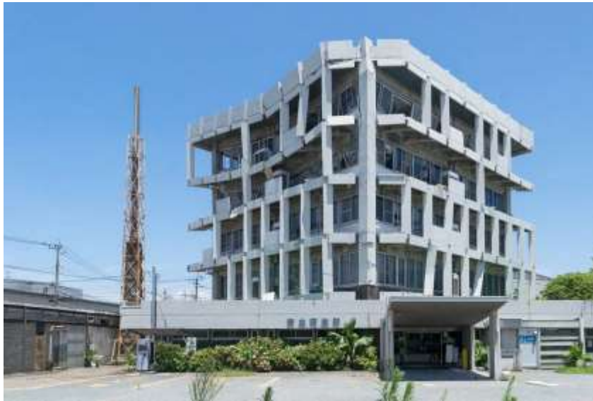
＜宇土市役所＞使用不能（ Is 値0.3未満） 4階部分がゆがんで倒壊寸前
