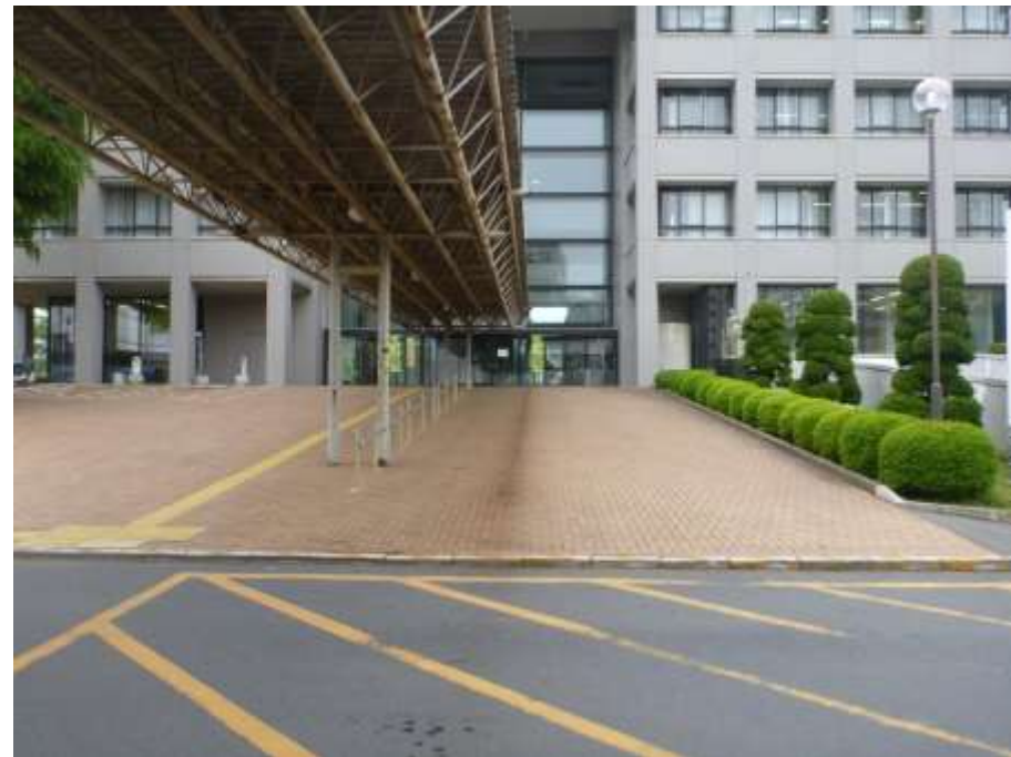
市役所入口の急な勾配
