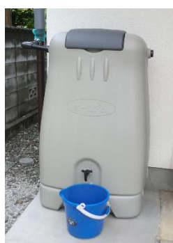
雨水利用タンク
