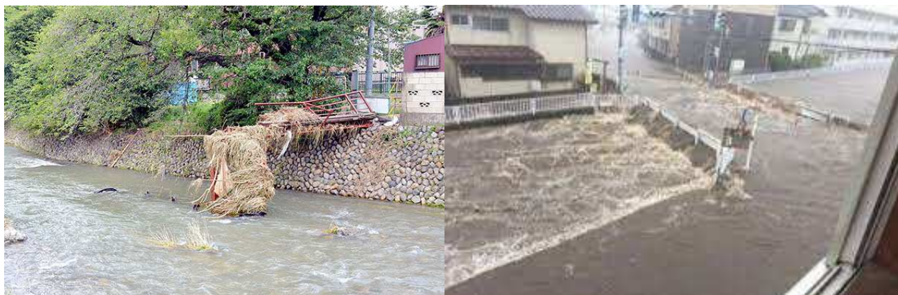
図 4.6-5 平成 28(2016)年に発生した台風 9 号被害写真
