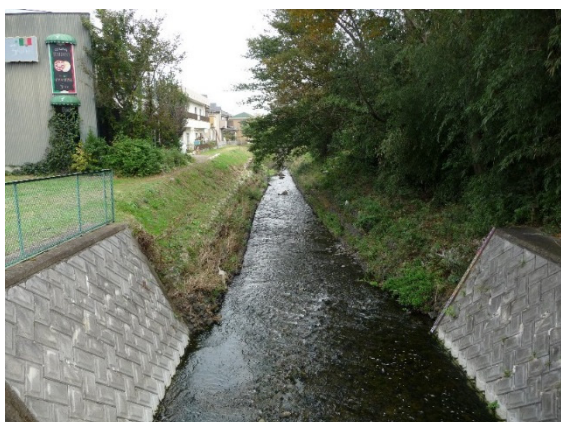
多自然型護岸に改修されている
