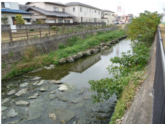
河床には礫や土砂が堆積している
