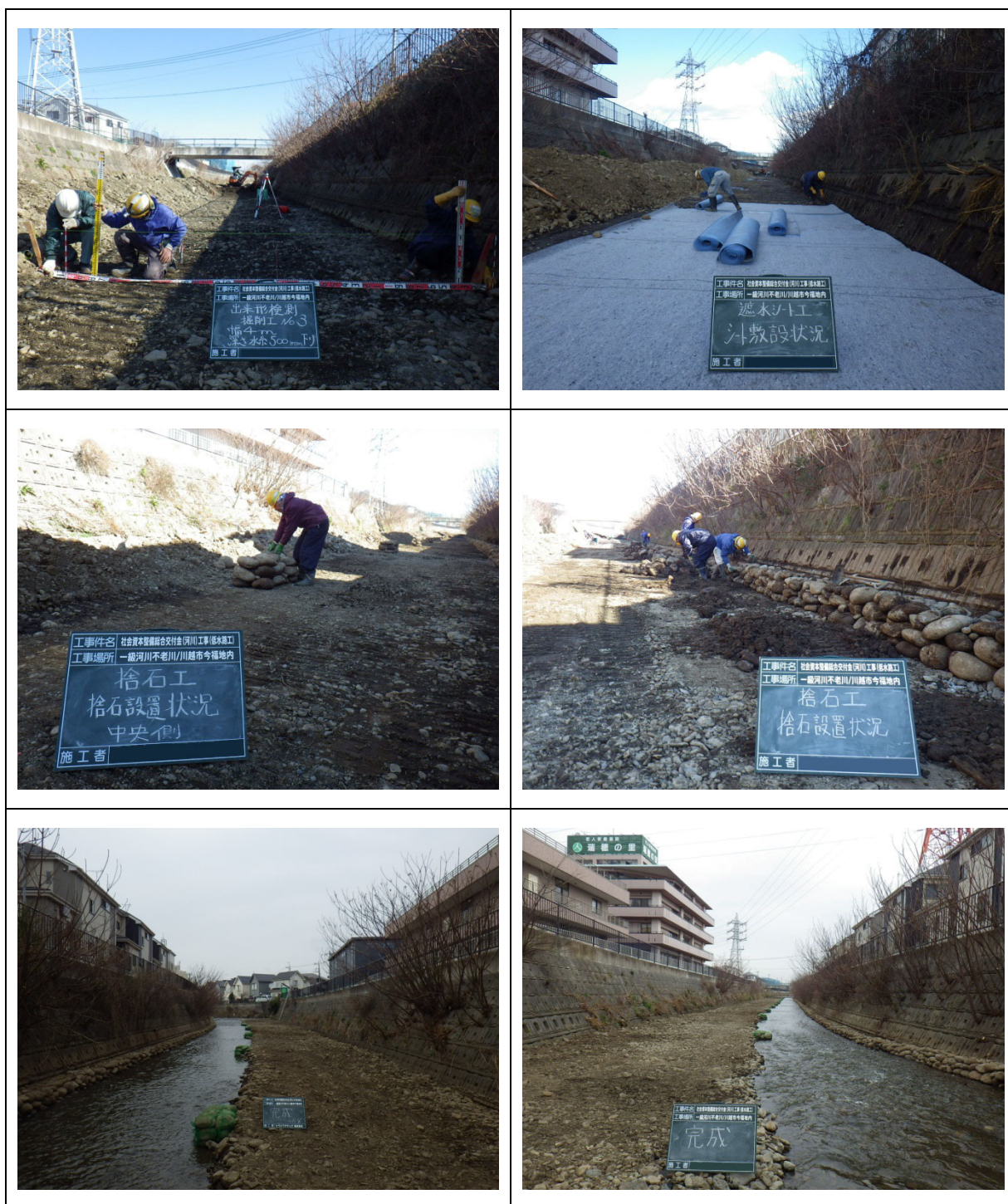
図 5.3 工事中および竣工時の状況
