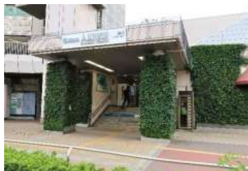
入間市駅駅舎の壁面緑化
