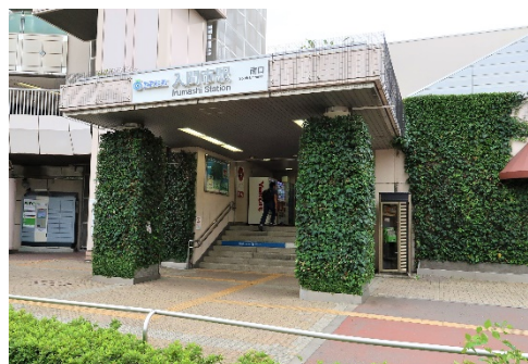
入間市駅駅舎の壁面緑化
