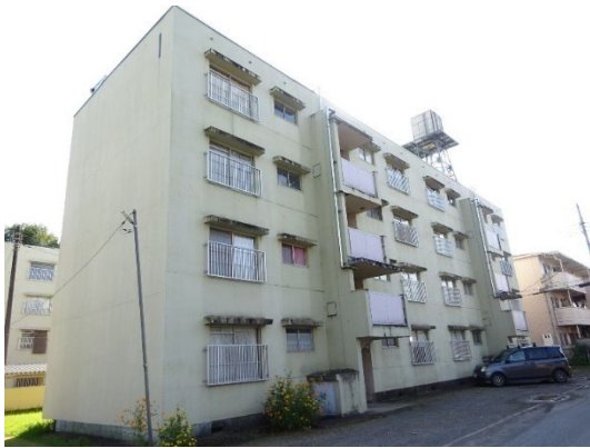
下河原団地 (1号棟) 全景
