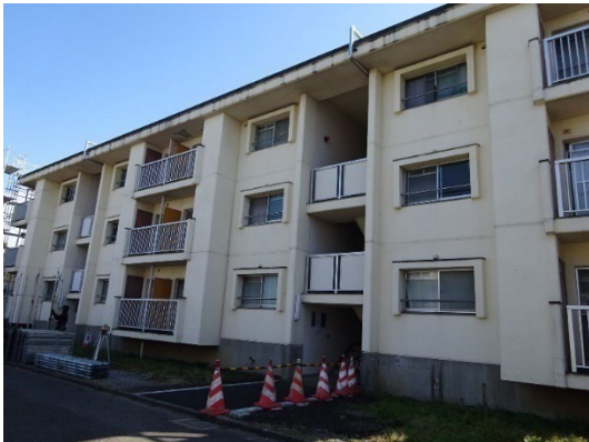
霞台団地（1号棟） 全景
