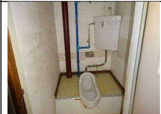
1・2号棟 和式トイレ
