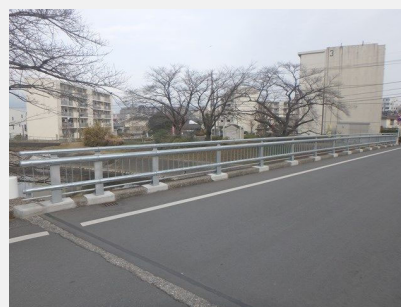
防護柵取替え、舗装打替え 等
