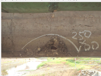
主桁補修(断面修復工) 等
