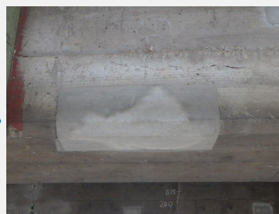
主桁補修(断面修復工) 等
