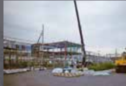
平成19年6月撮影 新駅舎建設中のようす
