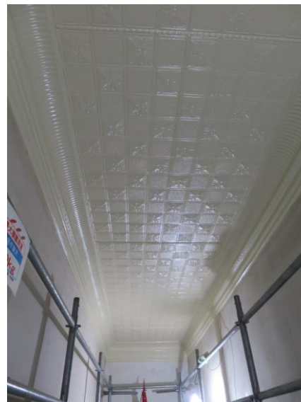
本館1階廊下天井 左:修繕前 右:修繕後
