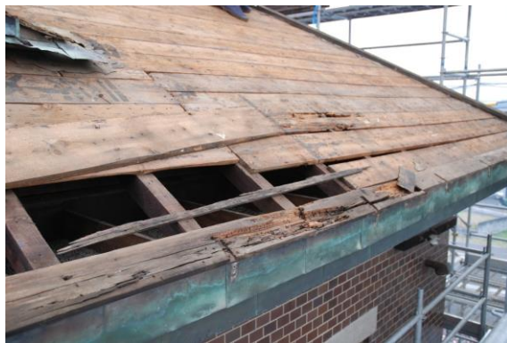
屋根板腐朽状況
