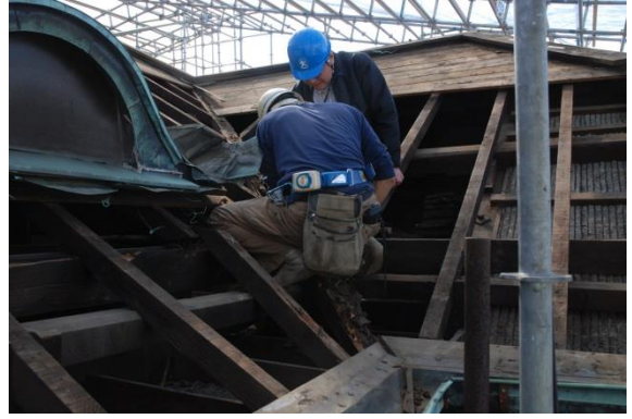
屋根修繕作業
