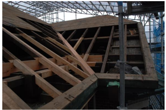
屋根小屋組繕状況
