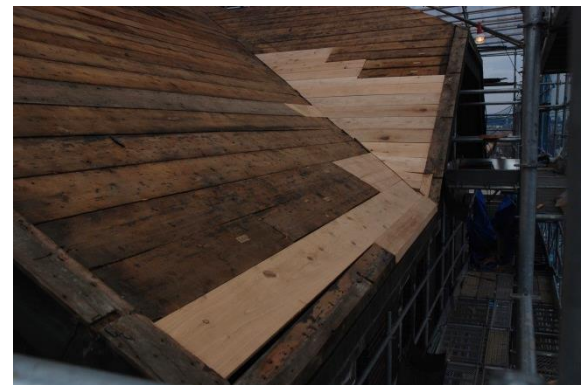
屋根板修繕状況
