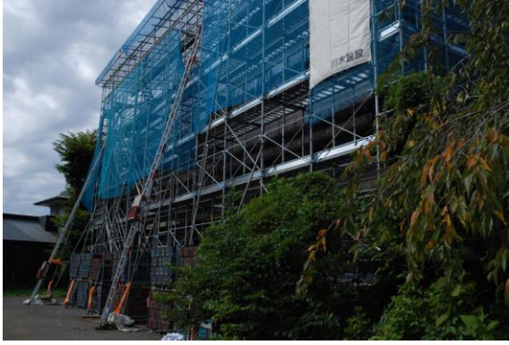
足場架設状況
