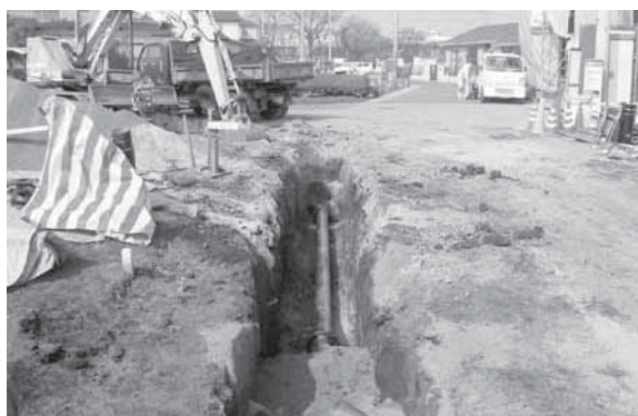
送水管布設工事
