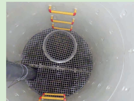
工事例● マンホール耐震化工事 既設のマンホールに強度と防食性を付与する工法
