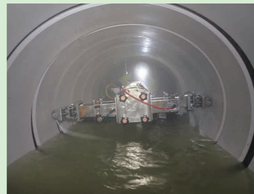
工事例● 汚水管耐震化工事 既設管の中に新しい管をつくり強度を付与する工法
