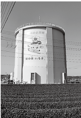
寺竹配水場 (平成30年3月竣工)
