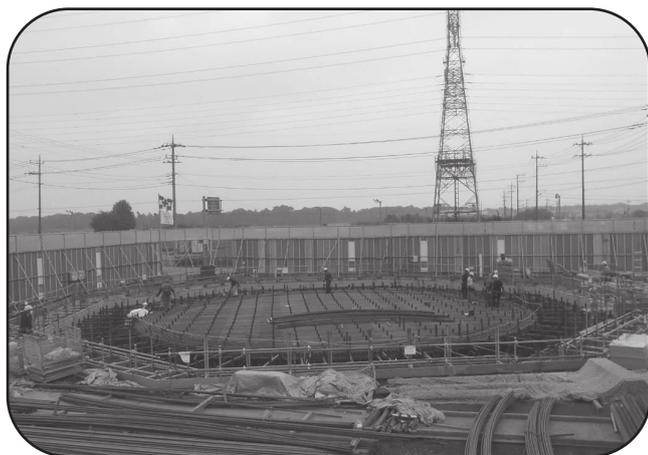
金子地区の配水を担っている南峯配水池と寺竹加圧場の老朽化に伴い、平成27年度から平成29年度にかけて、2つの水道施設を統合した配水機能を持つ寺竹配水場の新設工事を、寺竹加圧場の東側で実施しています。おかげさまで工事は順調に進んでおり、現在は配水池の躯体工事を行っています。平成28年10月末現在の進捗率は約34%です。
