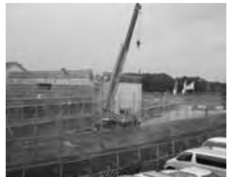
鍵山浄水場浄水棟工事の様子（10月末撮影）
