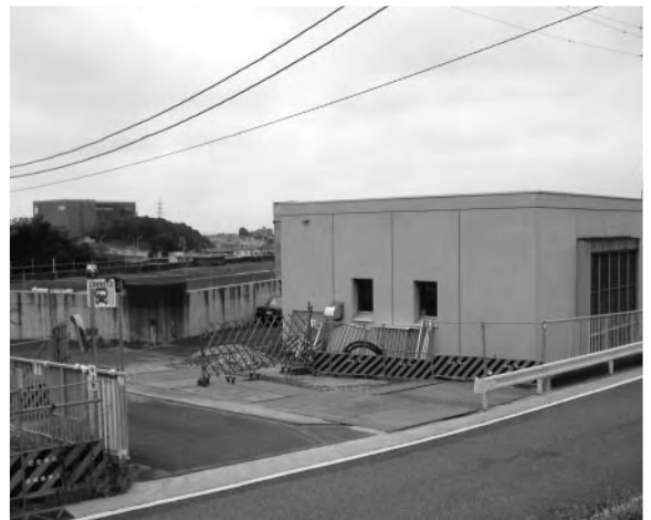
東金子配水場改修工事の様子（10月下旬撮影） 担当 水道工務課整備改良担当（内線2238）
