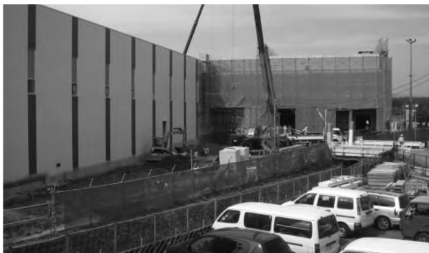
鍵山浄水場改築工事の様子（10月上旬撮影）
