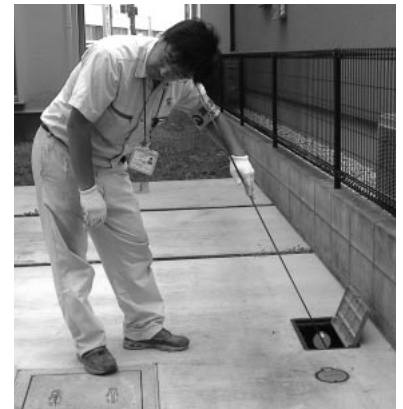
音聴棒を使用した漏水調査の様子
