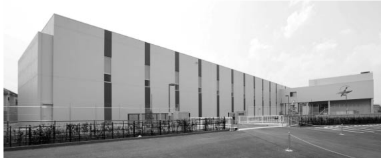
鍵山浄水場の全景
