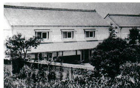
担保（繭等）保管のために併設されていた倉庫
