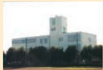
4月オープンに向けて改築工事が進む
