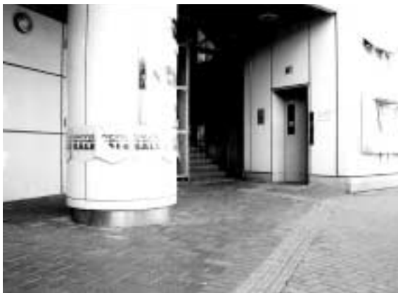
入間市駅エレベーター前の路盤（改修後）
