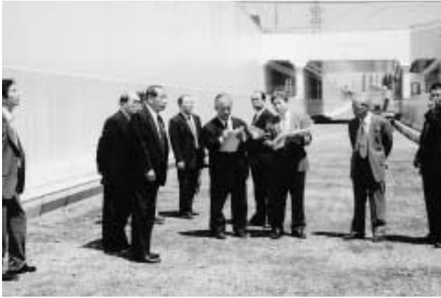
所沢市（施工中の新所沢駅前通り線、上新井地内の立体交差）にて
