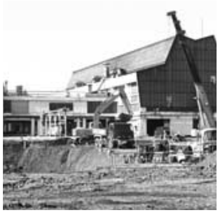
HOYAクリスタルの汚染土壌掘削工事
