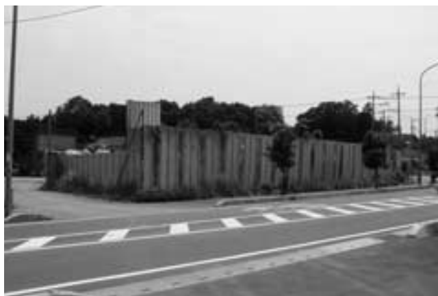
フェンスに囲まれた資材置き場
