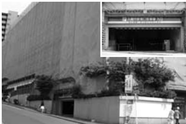
入間市駅南口自動車駐車場
