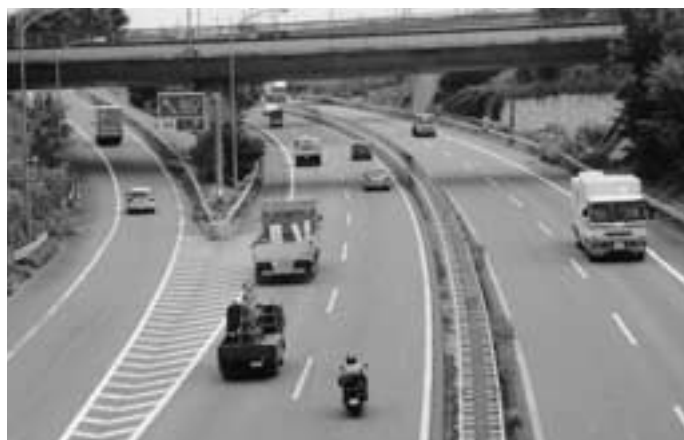
中央道との接続によって、交通量が大幅に増大した市内の圏央道
