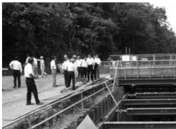
茨城県ひたちなか市（房田バイパス工事現場）にて
