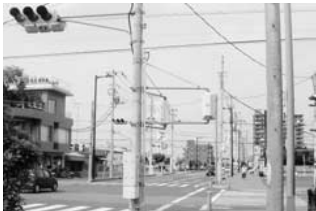
整備された駅前道路にかくれた危険箇所
