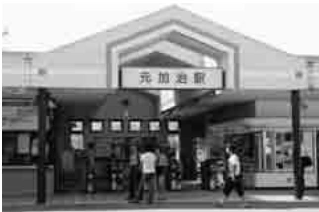
改良工事が始まり、駅員が復活し、利便性がより向上する元加治駅。
