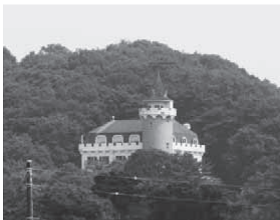
平成14年3月31日に閉館した旧入間グリーンロッジ
