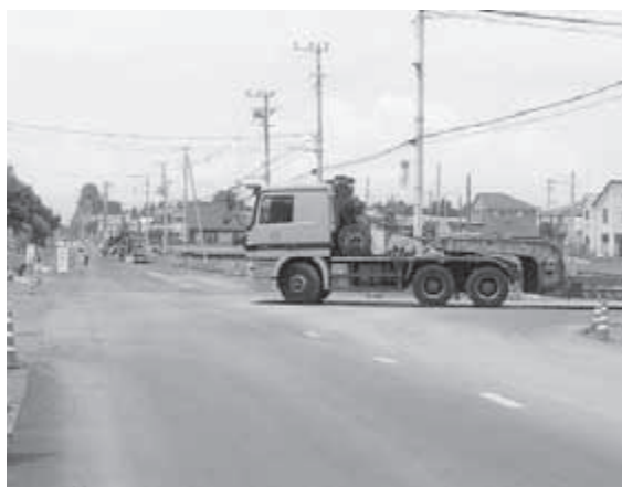
今秋、完成するアリット前の工事中道路
