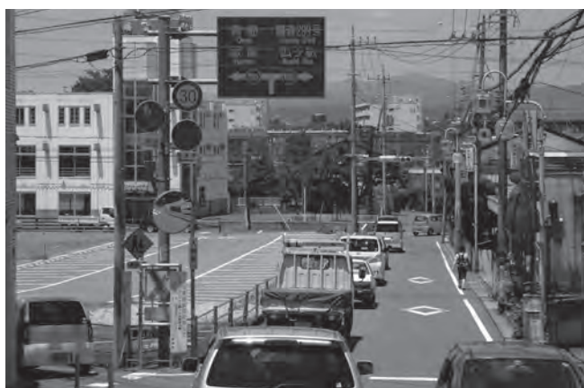
仙子の金子坂を南から望む。西側へ約2倍に拡幅する工事が、秋に始まる。
