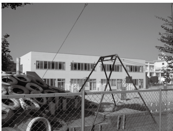
新校舎にエアコンが設置された西武小学校
