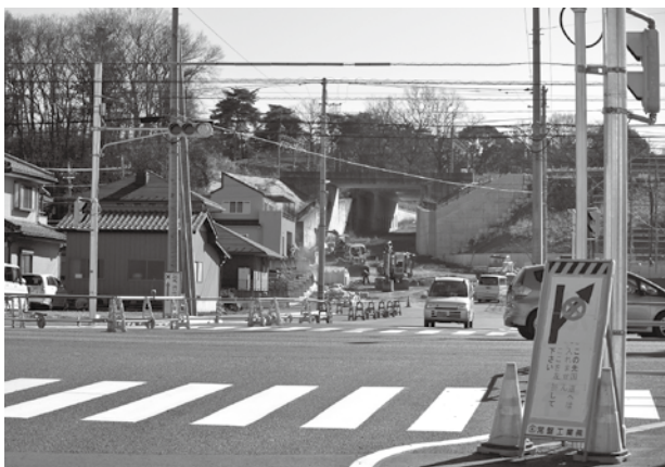
馬頭坂線進入交差点工事完成
