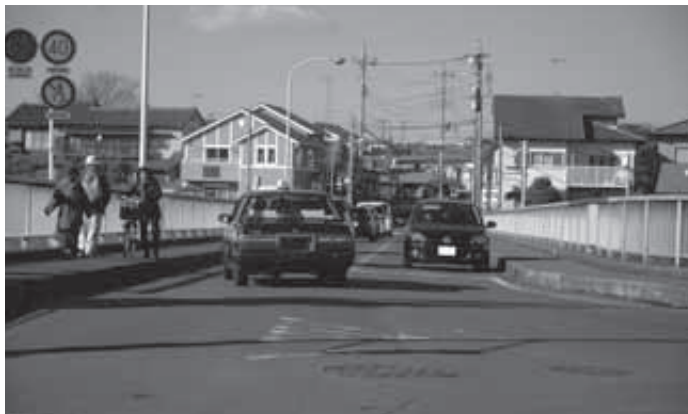
中橋は、歩道の拡幅や切下げが、補強工事と共に見込める。
