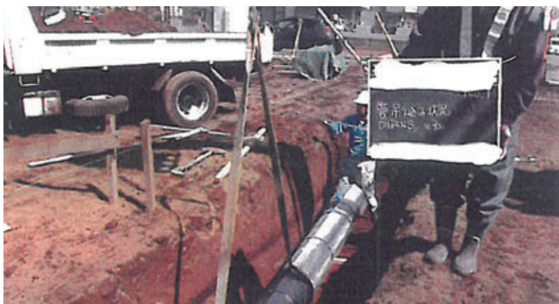
水道工事の情景
