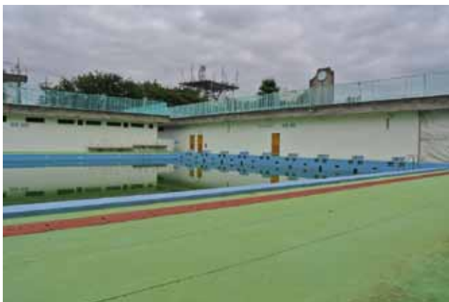
プールサイドの塗装に熱交換塗料の採用を
