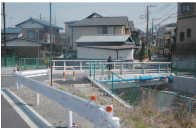
仏子の県道北の前掘川に架かる鉄筋コンクリート製の『西武6号橋』
