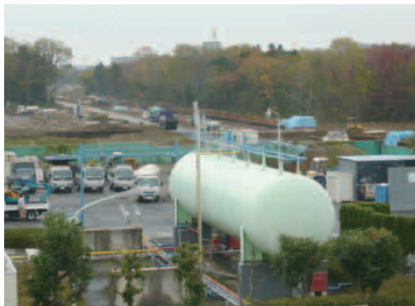
昭島市留保地工事中
