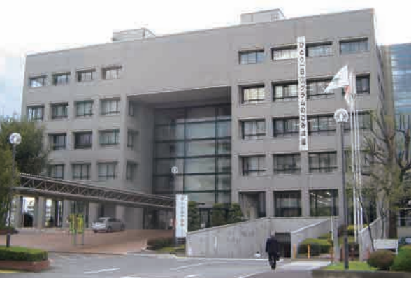
市役所の耐震化も公共施設マネジメントの重要な課題
