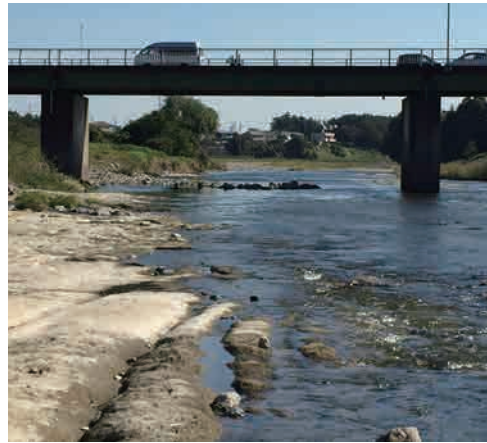
11月から耐震補強工事が始まる「中橋」
