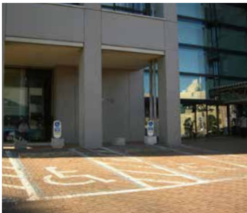
市役所の障害者用駐車スペース
