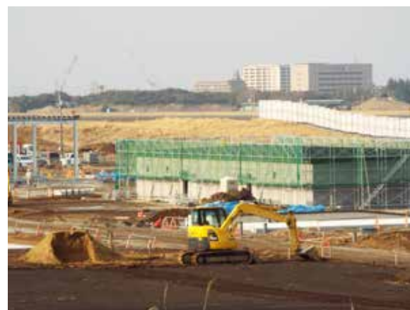
病院北側に建設中の自衛隊の大燃料施設
